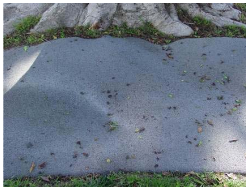
Pour in Place next to tree
